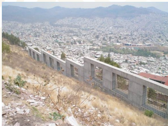
Muro de contención para caídos de roca En la Col. La Pastora, GAM
