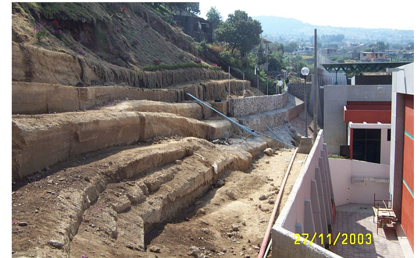
Estabilización de laderas, Milpa Alta, 2003
