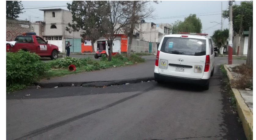
Agrietamiento del terreno en Tláhuac, 2016
